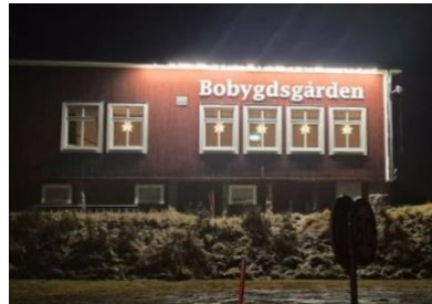
Fasadbelysningen lyser upp fint
